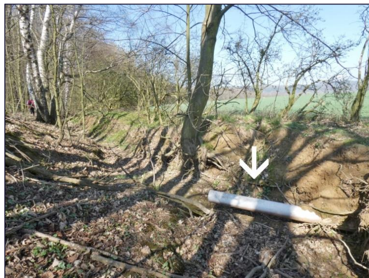
Pramen Vražného Pod Lučickou stráží, meliorační svod v korytě potoka pod lučickou silnicí.
