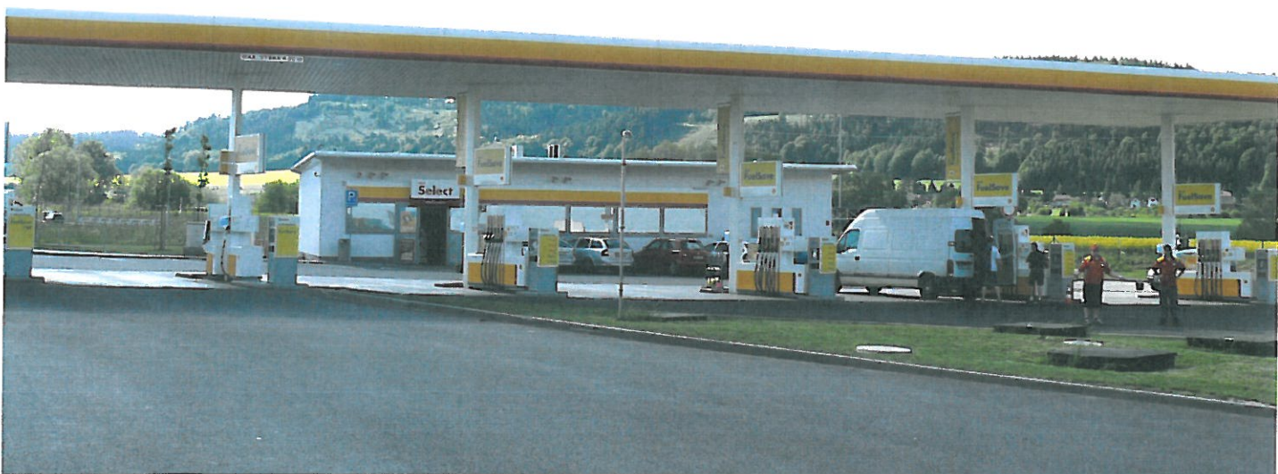
Levostranná dálniční odpočívka D1 Čerpací stanice PHM fy SHELL Vražné č.p. 264
