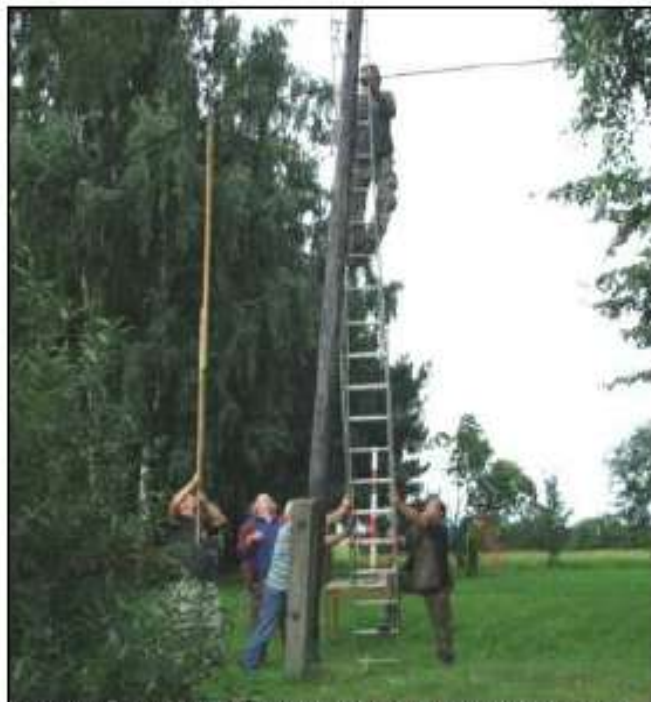
Komplikované přesunování a dopínání přírodního kabelu el. vedení
