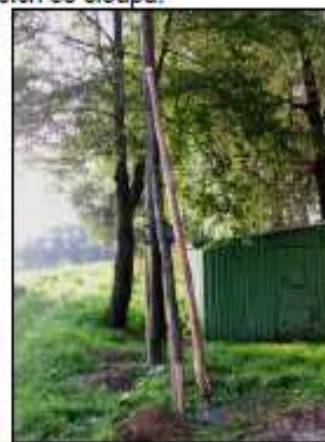
Již vyrovnané a zabezpečené sloupky. Nový (světlý) sloup, šikmo podepírá sloup rohový.
