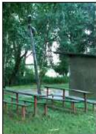
Nebezpečně ukloněné sloupky ve vlhké půdě pod areálem
