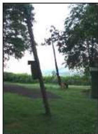
Nebezpečně ukloněné sloupky ve vlhké půdě pod areálem
