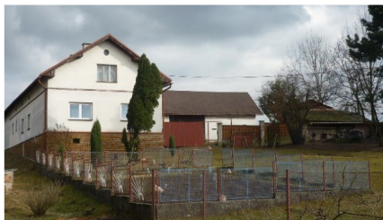
Dům č. p. 3 - v jeho zahradě jsou již jen základy původní školní budovy
