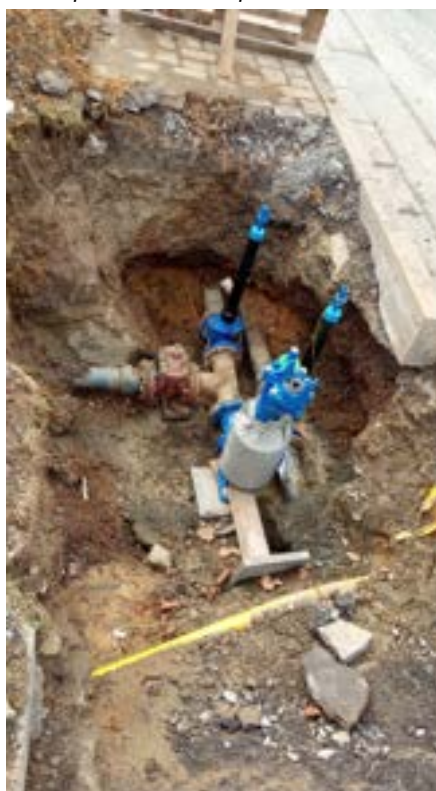
Po opravě - Lesní správa
