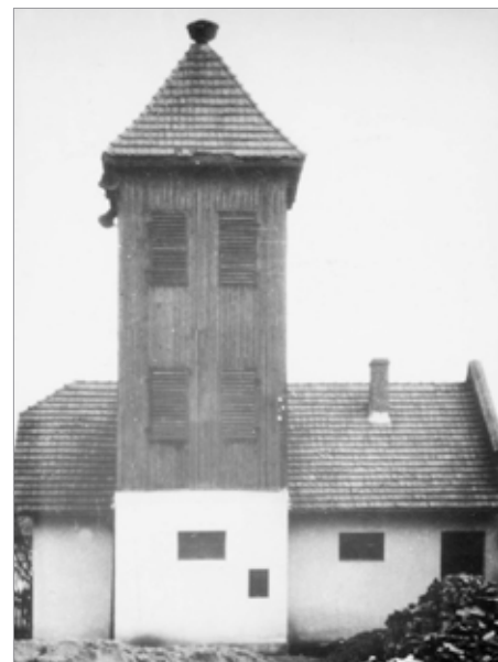
První podoba Budova hasičské zbrojnice byla dokončena v roce 1912. Snímky archiv J. Smolky
