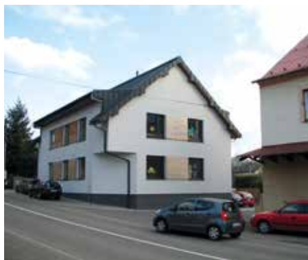
Budova čp. 178 po rekonstrukci.
