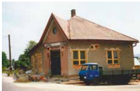
Fotografie z průběhu rekonstrukce v roce 1994
