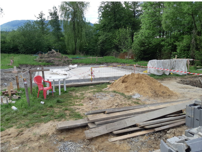
Zrání betonu objektu dětského brouzdaliště
