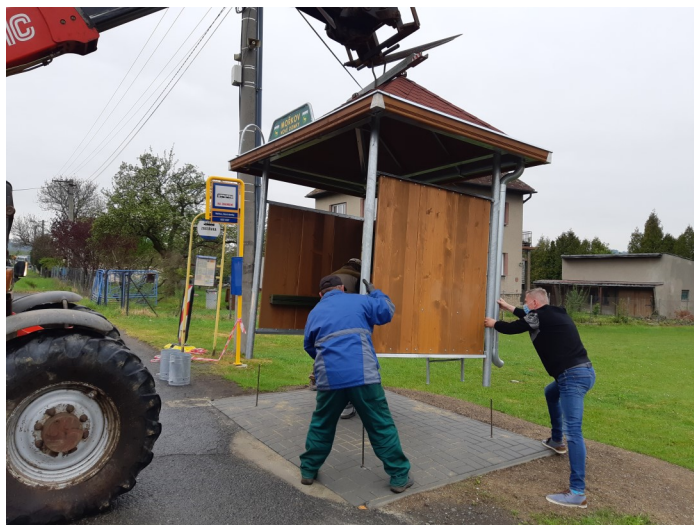
Osazování zastávky na připravené místo
