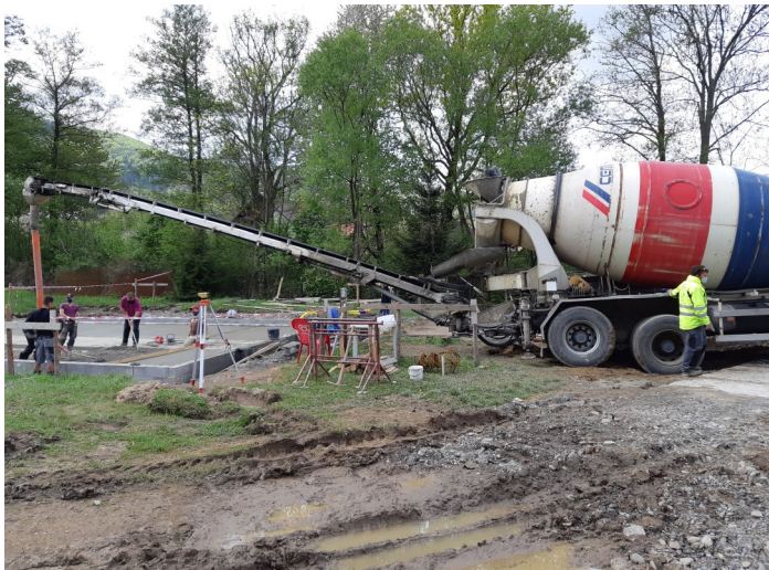
Betonáž pod plastovou vanou dětského brouzdaliště
