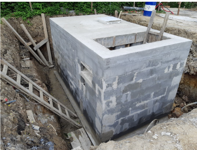
Technologický objekt dětského brouzdaliště před izolačním nátěrem
