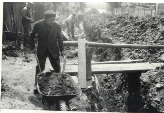
Výstavba vodovodu v obci a pracovní nasazení spoluobčanů při budování vodovodní sítě.
