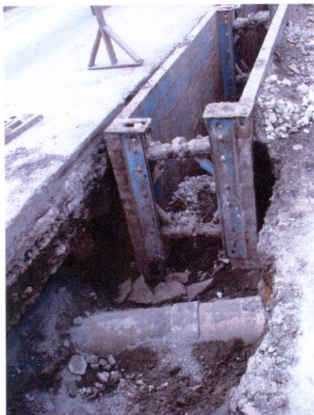
Výkop pro kanalizaci
