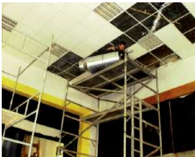
Kinosál — montáž nové vzduchotechniky
