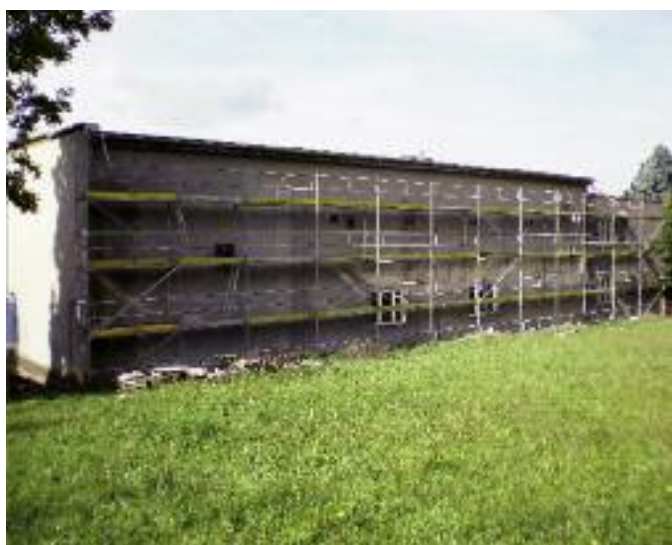
Zadní stěna před zateplením
