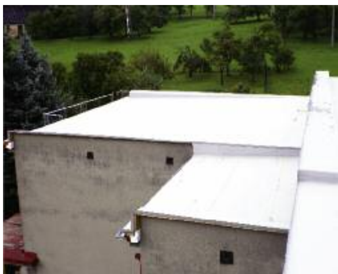
Střecha sokolovny byla kvalitně zateplena
