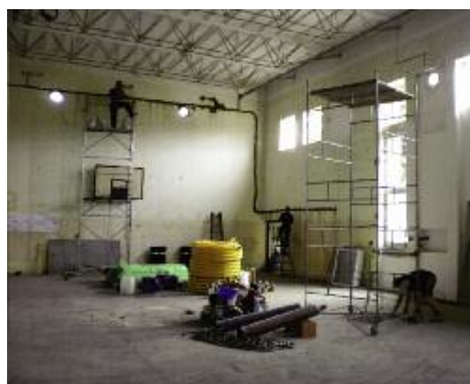
V tělocvičně se instaluje nové osvětlení
