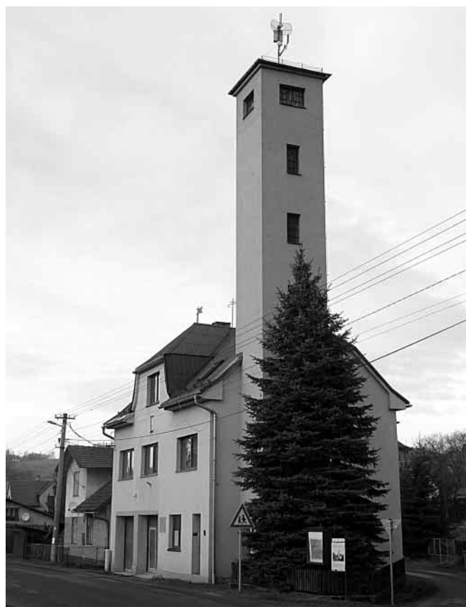
Hasičská zbrojnice v Metylovicích, současnost
