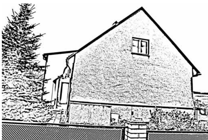
Stylizovaný pohled na dům č.p. 133 Vavřina Němce, kde po válce stávala malá dílna.
