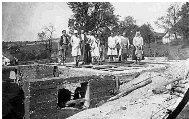
Stavba domku č.p. 279, který nechala postavit Antonie Bílková.
