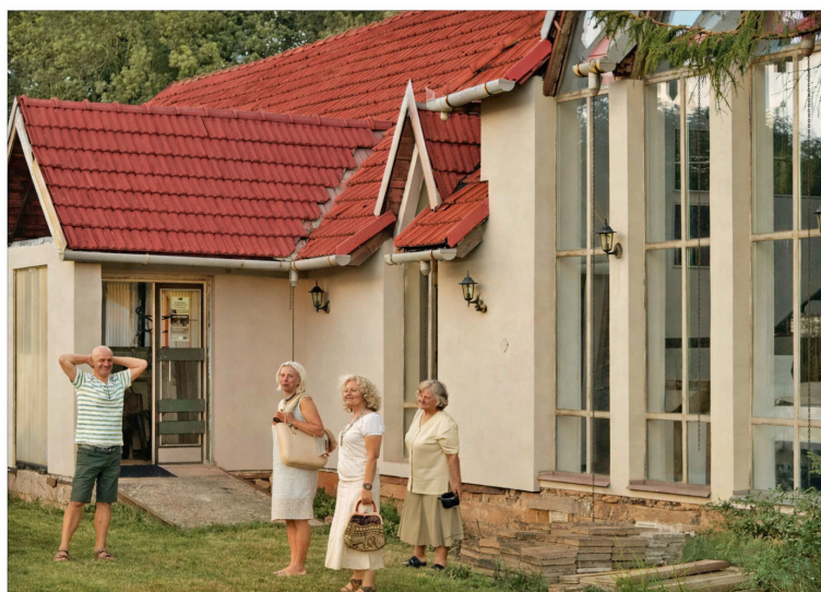
Nová přístavba galerie
