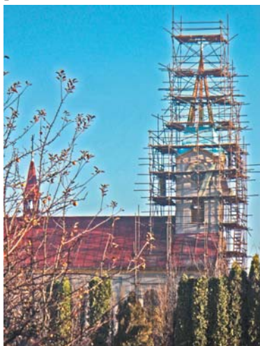
Oprava věže kostela
