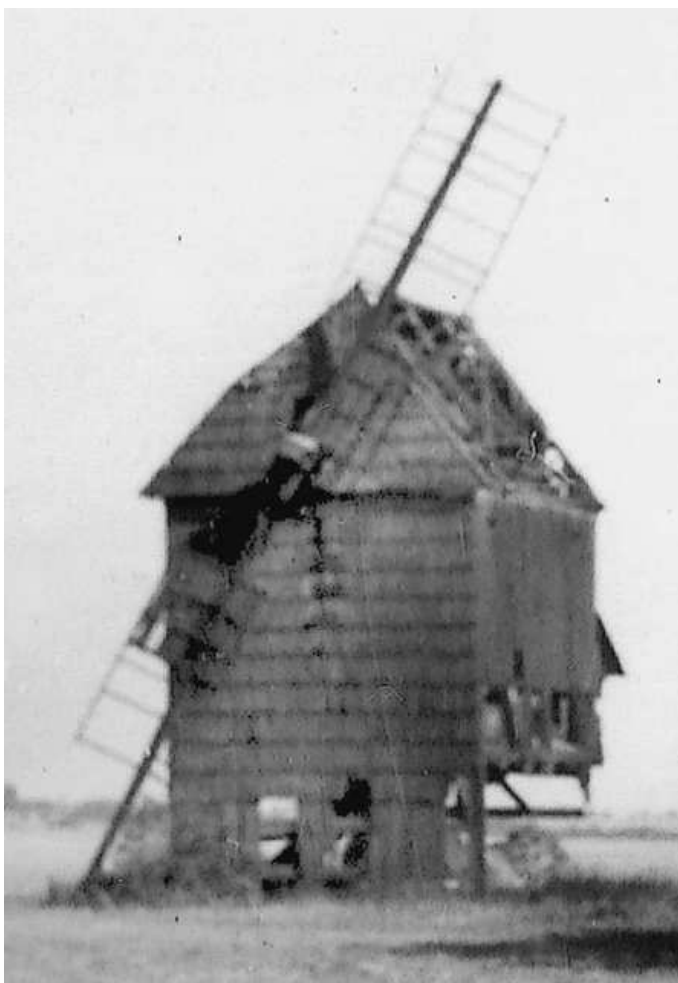
Raabův mlýn před obnovou v roce 1970
