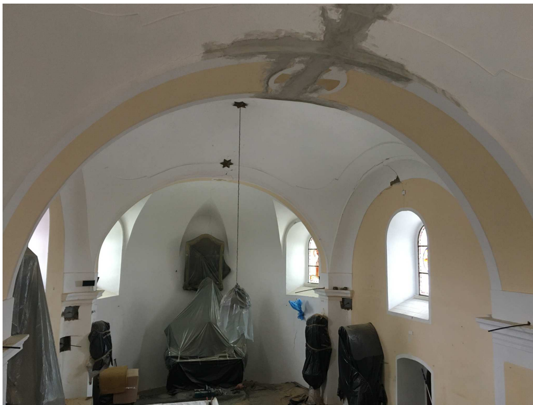
opravené praskliny oblouku včetně táhel
