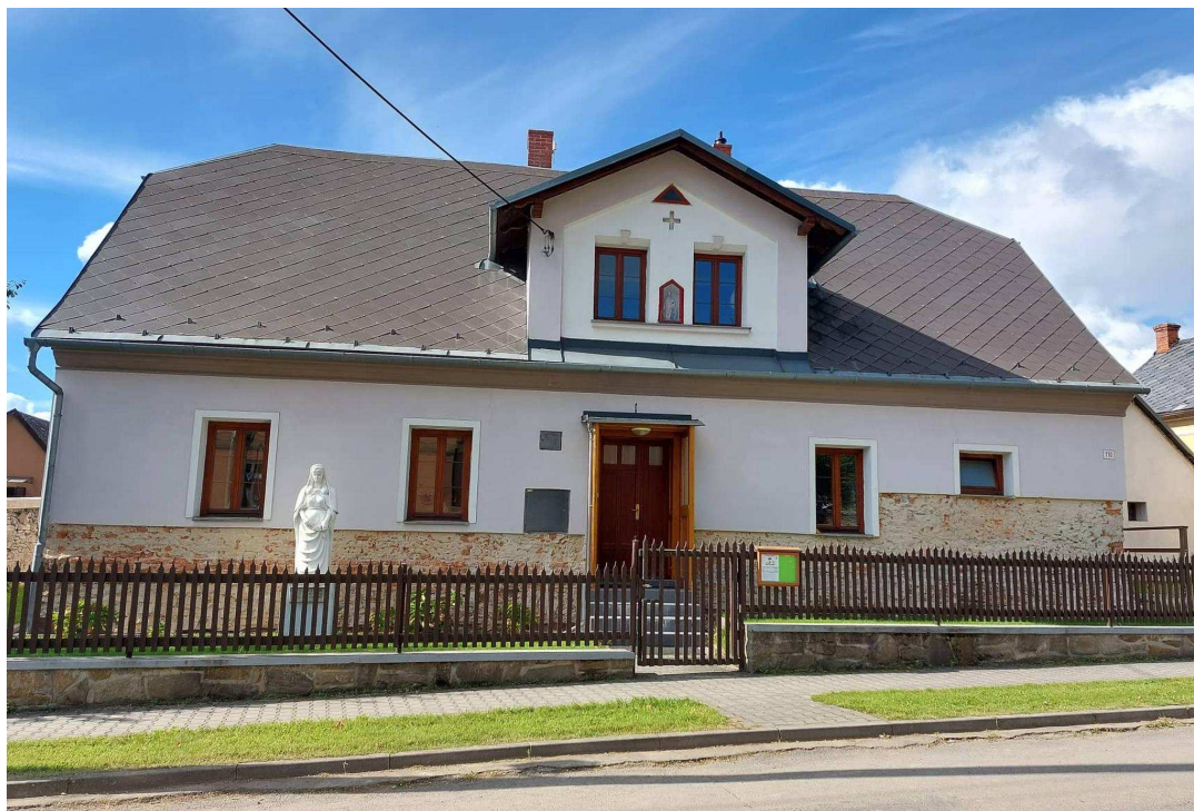
pohled na faru z přední části (odstraněna omítka)
