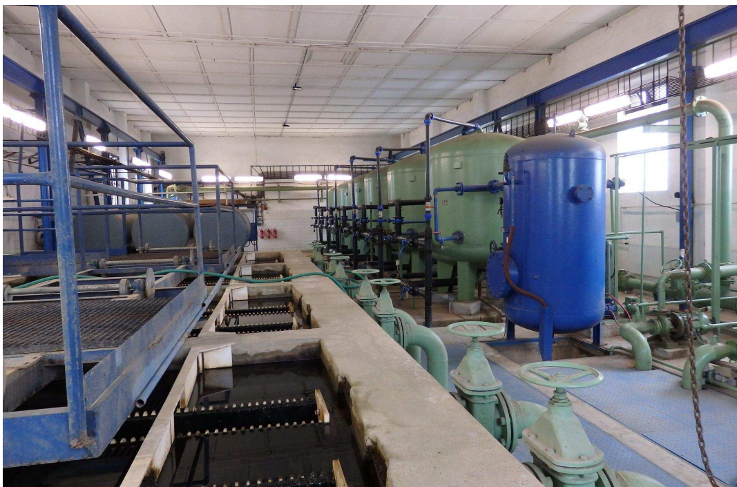
Úpravna vody v Luhách
