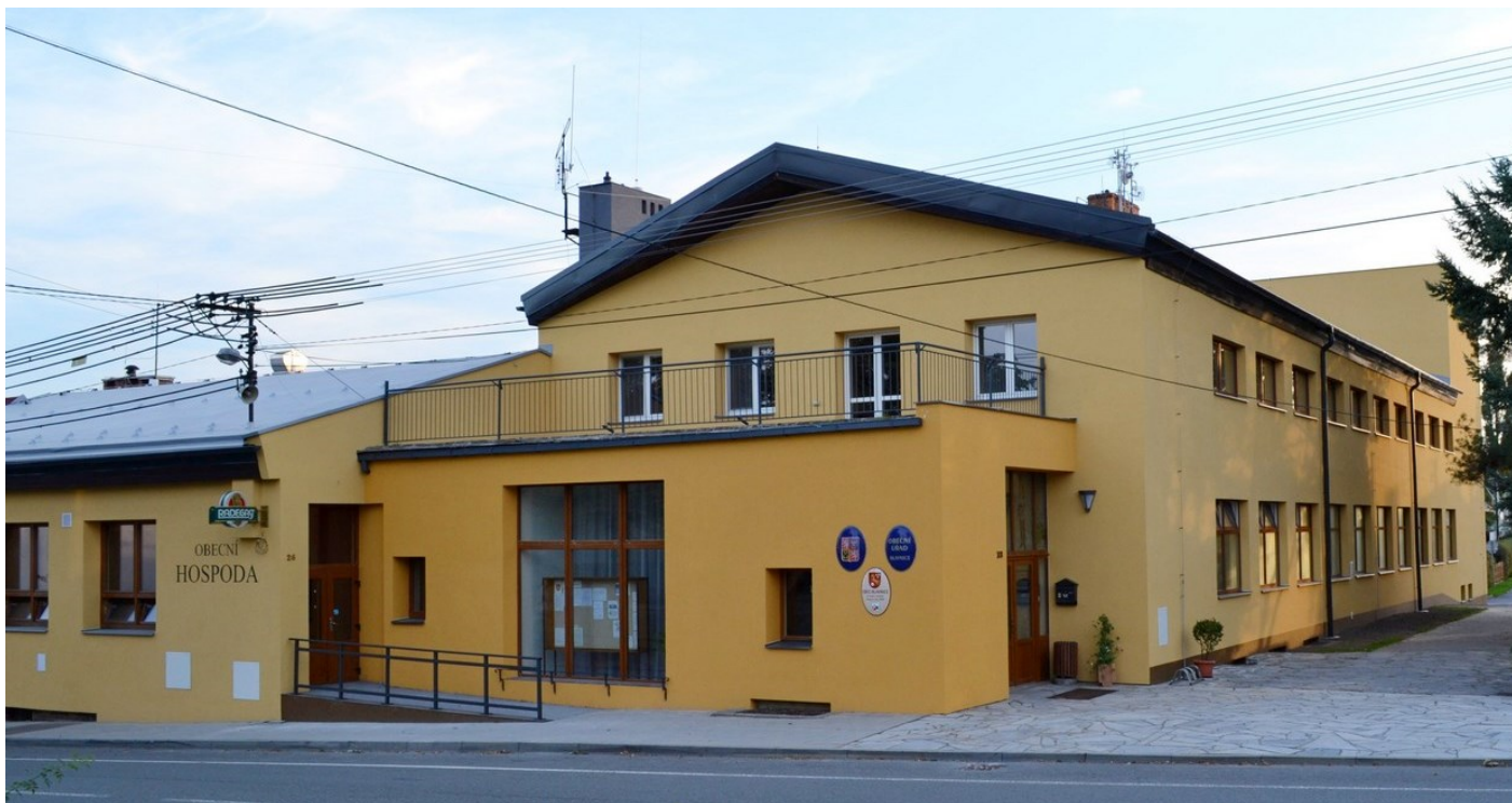
Kulturní dům, Obecní úřad a Obecní hospoda Hlavnice po rekonstrukci.
