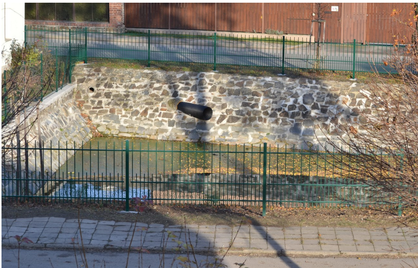
Dolní požární nádrž po opravě
