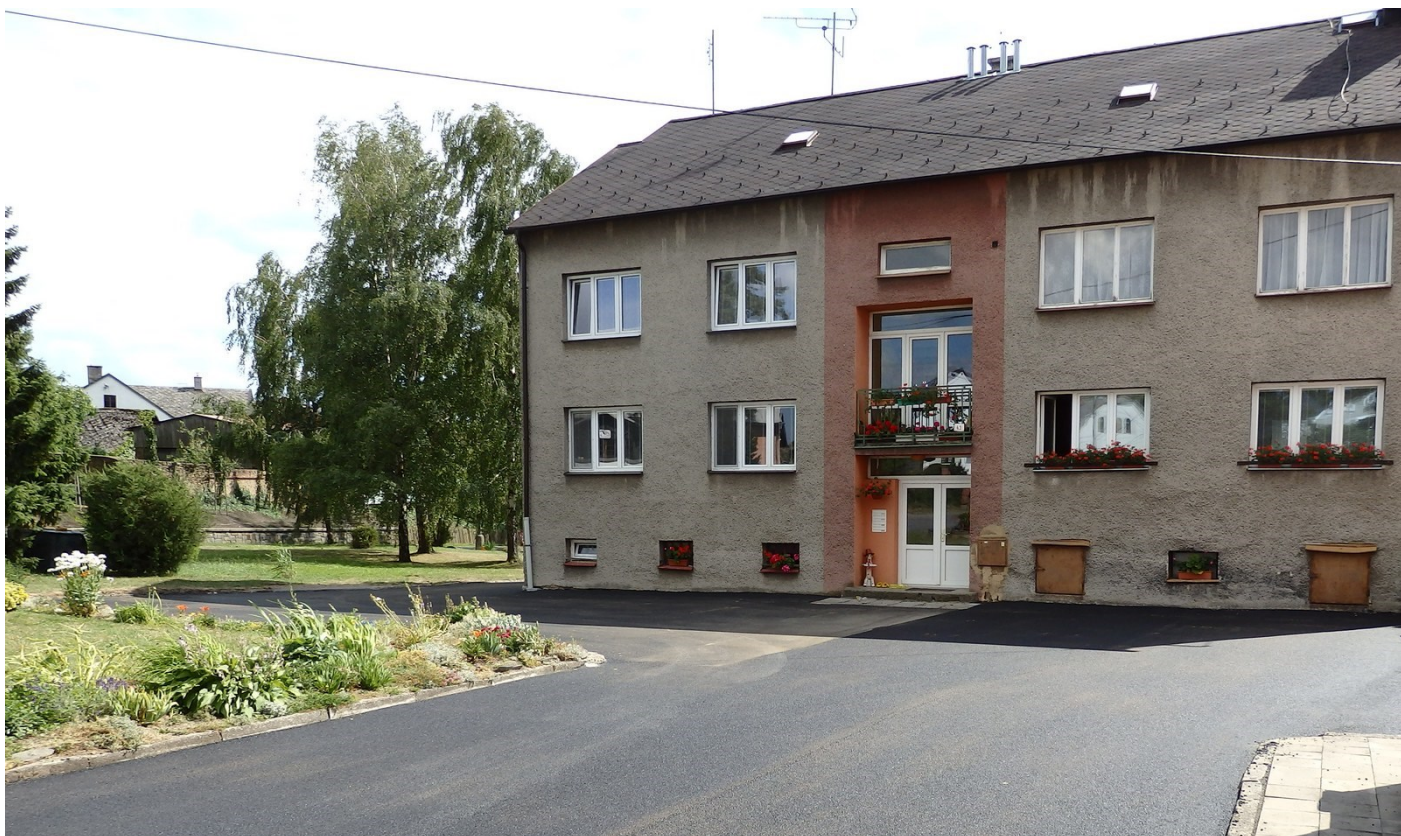
Příjezdová cesta u bytovek
