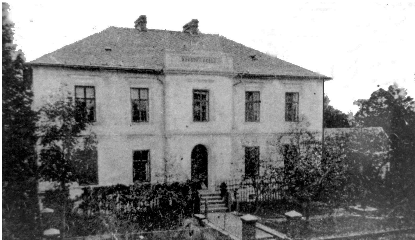
Základní škola Hlavnice (1915)
