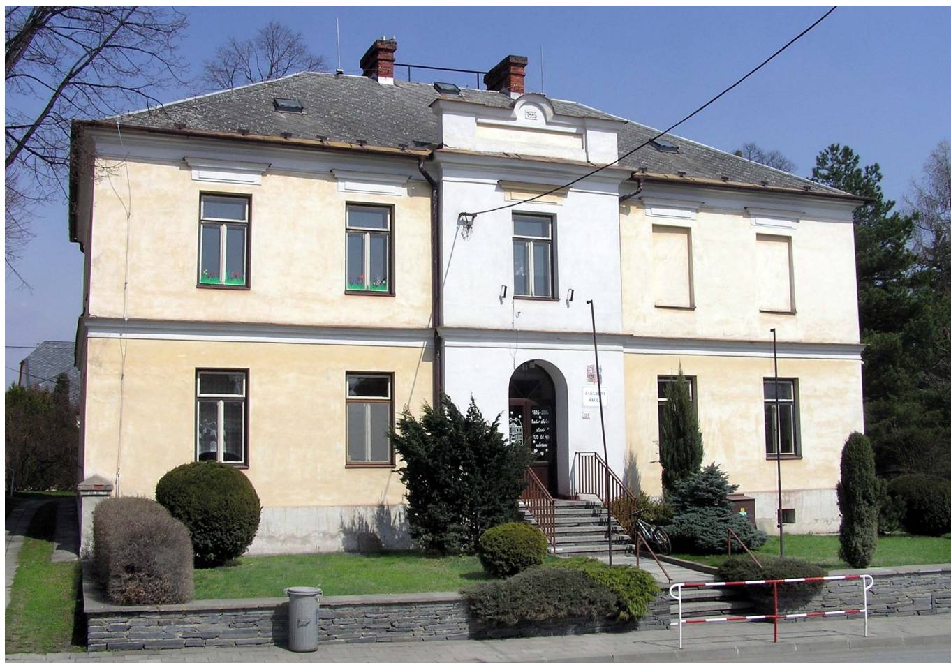
Základní škola Hlavnice (2006)
