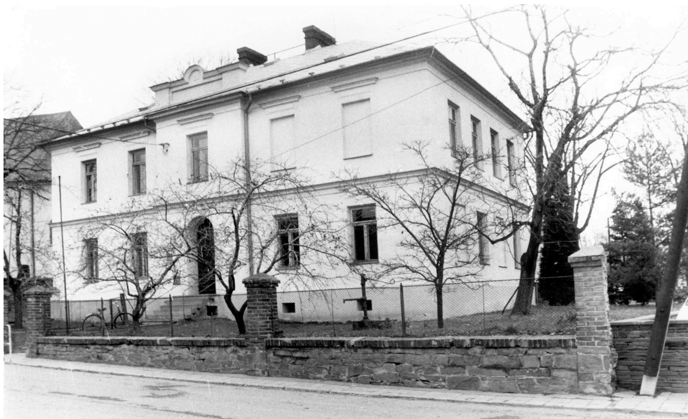
Základní škola Hlavnice (1970)
