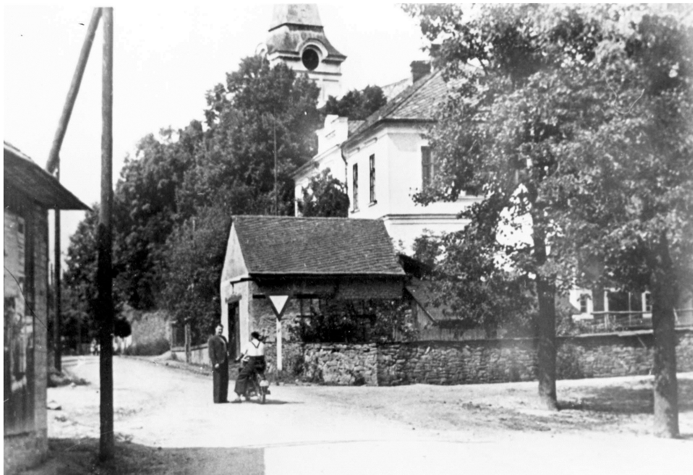
Kůlna základní školy Hlavnice (1930)
