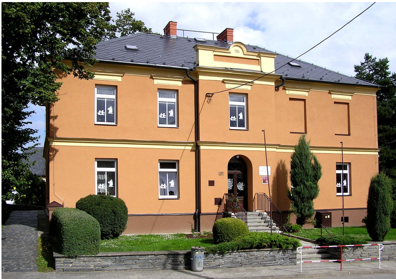
Základní škola Hlavnice po opravě (2010)
