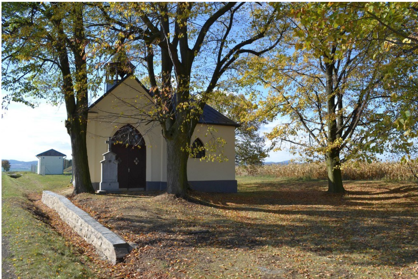
Kaple (směr Mladecko) po opravě
