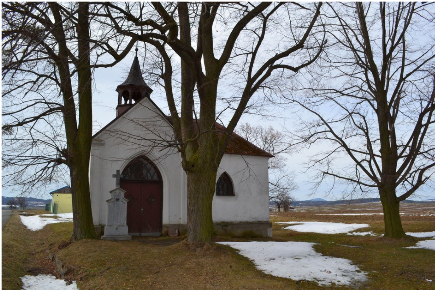
Kaple (směr Mladecko) před opravou
