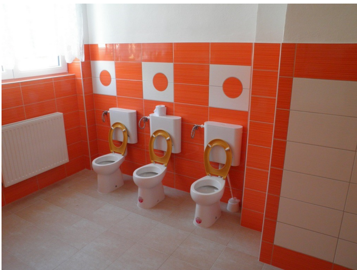
Sociální zařízení po rekonstrukci
