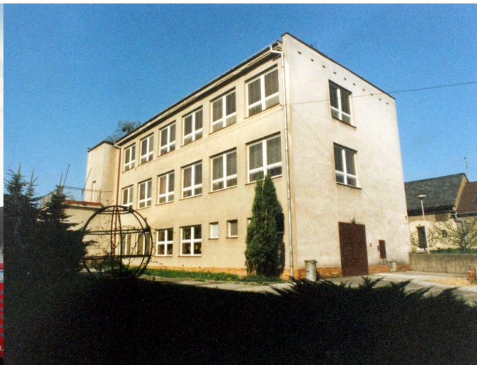
Mateřská škola před rekonstrukci
