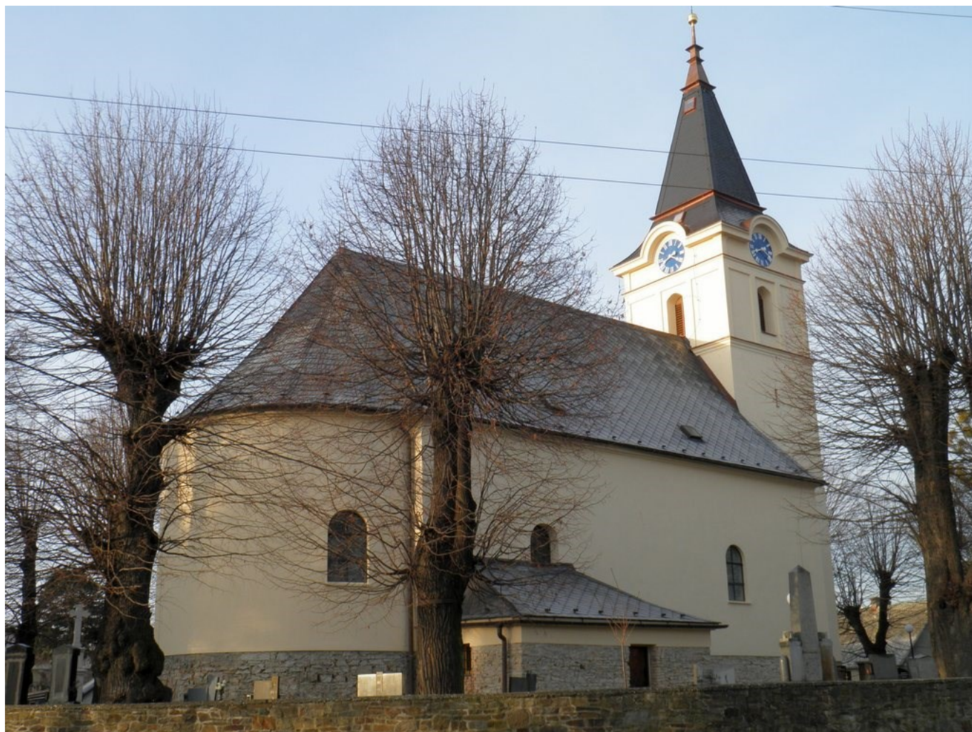
Kostel Nejsvětější Trojice v Hlavnici po opravě - 3.12.2013
