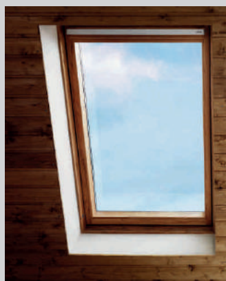
Výměna starého střešního okna za nové
