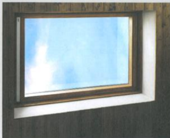
Výměna starého střešního okna za nové
