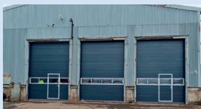
Výměna vrat na budově sběrného dvora (475 988,00 Kč)
