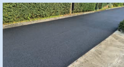
Rekonstrukce místní komunikace okolo Stamaru (1 331 055,61 Kč)
