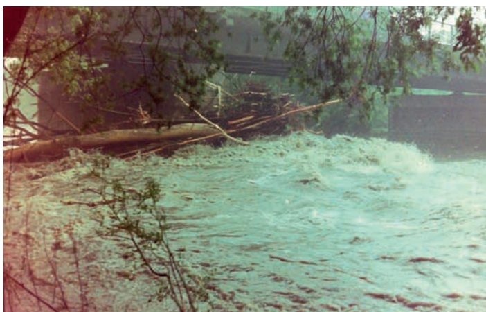
▲▼ Náplava stromů u pilíře mostu přes řeku Ostravici. Tyto stromy už v 90. letech min. století narušily stabilitu pilíře, který pak v roce 2009 vyklonil.
