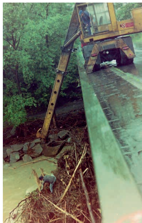
▲▼ Náplava stromů u pilíře mostu přes řeku Ostravici. Tyto stromy už v 90. letech min. století narušily stabilitu pilíře, který pak v roce 2009 vyklonil.
