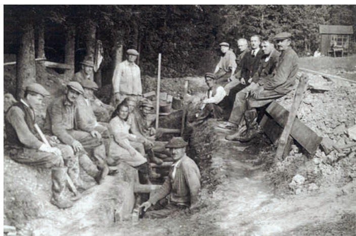
▲ Stavba vodovodu v Bašce (1947–1957) – v místech nad přehradou.
