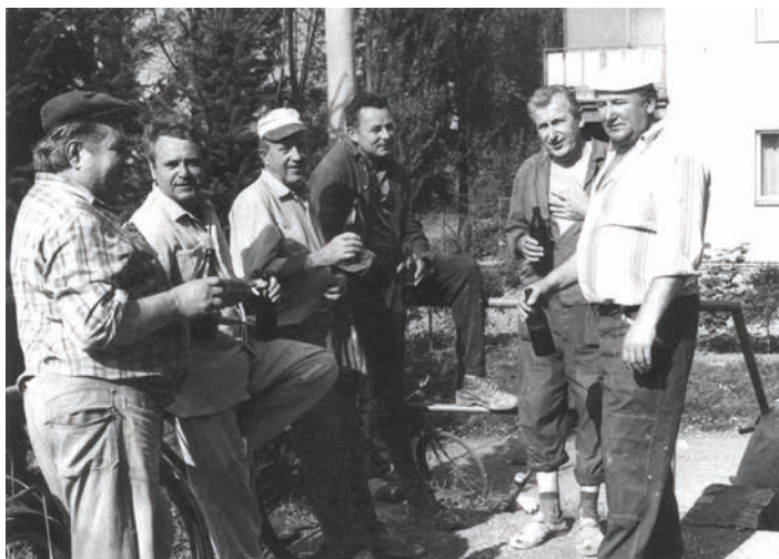
▲ Stavba Kulturního domu v Bašce – r. 1985.
