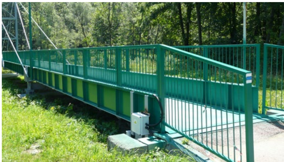
Lávka přes řeku Ostravici v Hodoňovicích na Kamenci, foto: Vratislav Kryl
