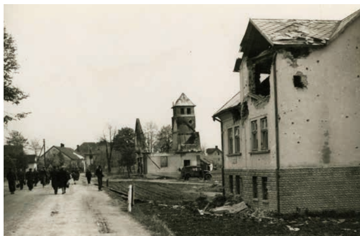
Poškozený dům F. Juroka, zbrojnice hasičské zbrojnice
