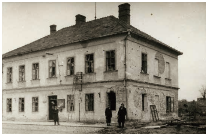
Poškozená budova č. p. 119 – MNV a poštovní úřad, učitelské byty
