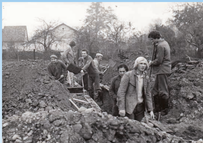
▲ Archivní fotografie ze zahájení stavby MŠ v Bašce (výkopy a základy 10. 9. 1977 – 22. 12. 1977). Mateřská škola byla uvedena do provozu 5. 10. 1980.
