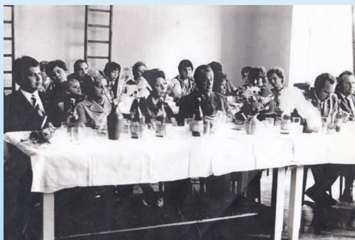
▲ V první polovině sedmdesátých let min. století se uskutečnila nákladná rekonstrukce ZŠ a MŠ v Kunčičkách u Bašky. Po jejím dokončení se v tělocvičně ZŠ konalo slavnostní zahájení provozu školy, kterého se zúčastnili – předseda MNV Karel Řeha, inspektorka Okresní školní inspekce Jarmila Konečná (třetí zleva) a další hosté.
