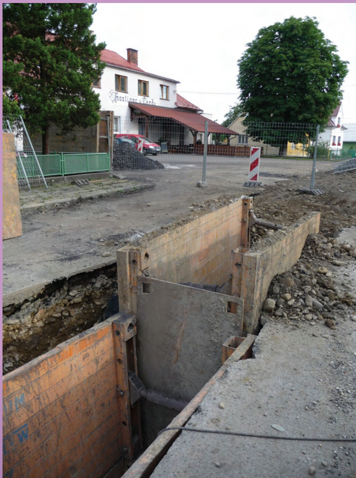
Pokládka kanalizace v části Hodoňovice.
