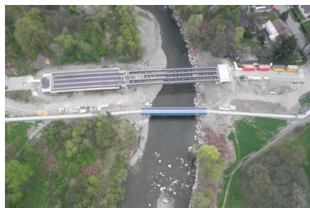
Stavba mostu přes Ostravici (Ing. Hromádka)
