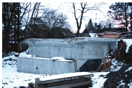
Připravený pilíř pro nový most
