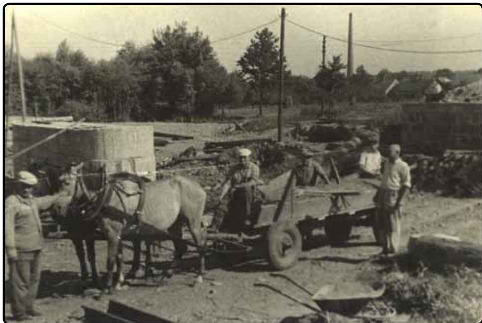
Archivní fotografie z roku 1959 – Štěrka na stavbu mostu přiváželi také někteří z kunčických zemědělců – v pozadí provizorní lávka.
