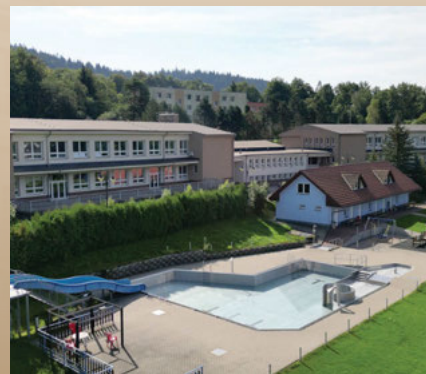
Letecký snímek zrekonstruovaných školních objektů, mini aquaparku a dětského hřiště se zázemím (r. 2023).
