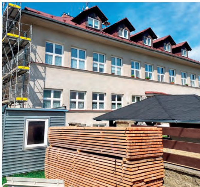
práce na budově MŠ Šance
