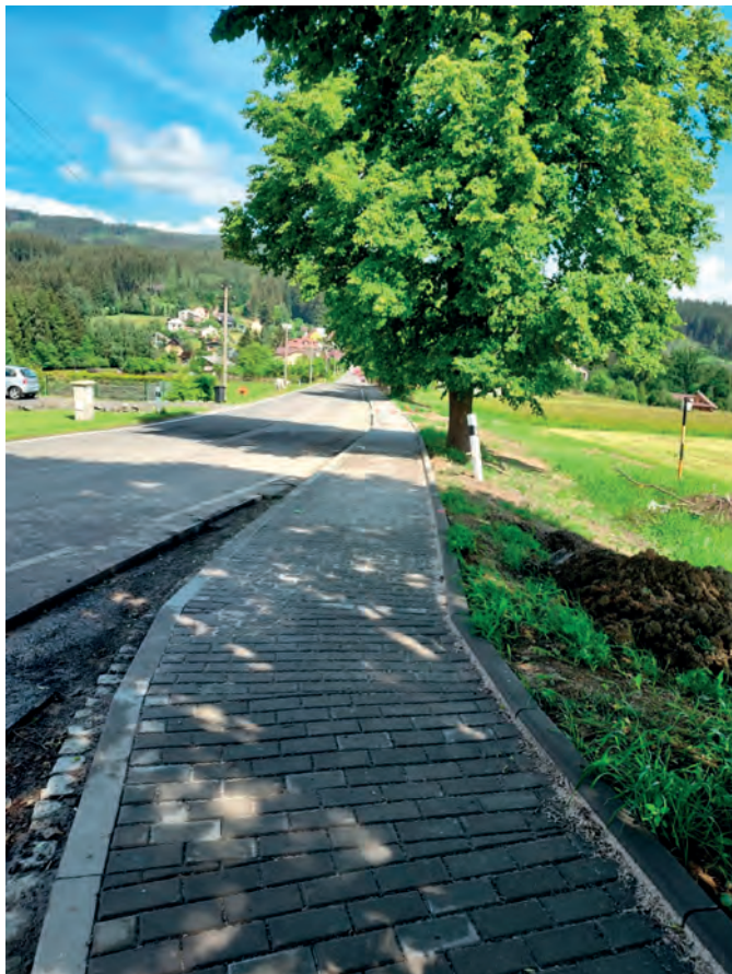
dokončení chodníku v úseku Kaplička-Rynštoky
