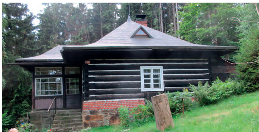
Dom Lubenika po rekonstrukcji
