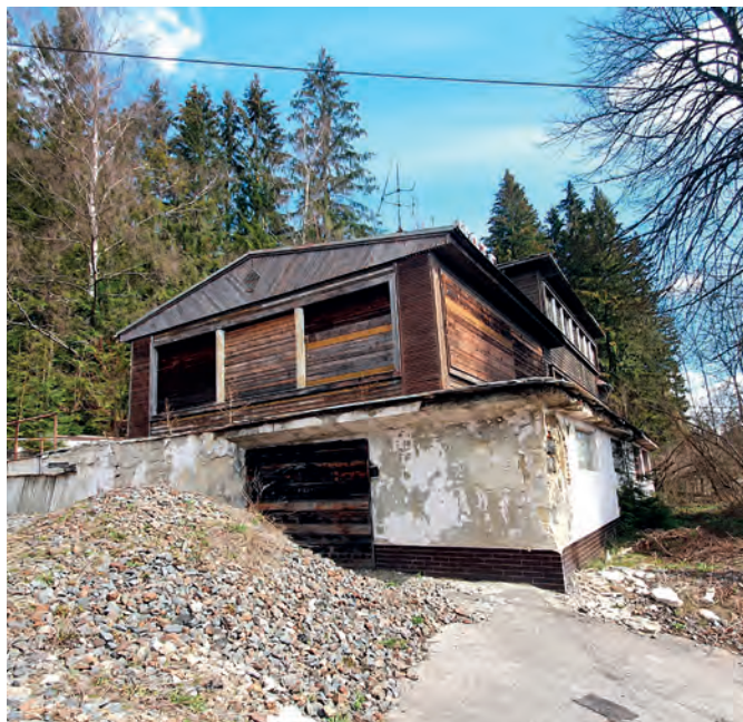
Objekt před demolicí
