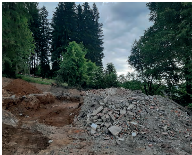
Objekt po demolici před odvozem sutin a terénní úpravou
