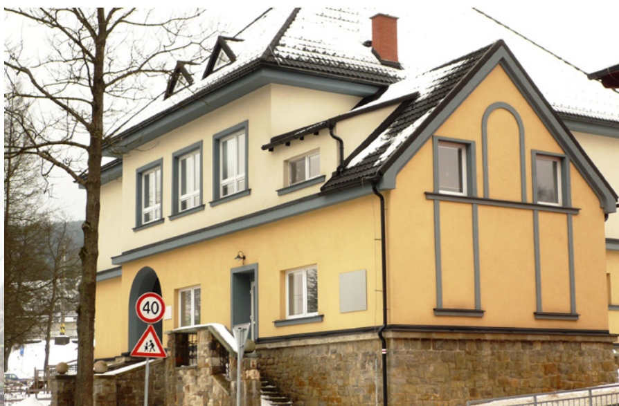
Testovací centrum v budově staré školy čp. 333
