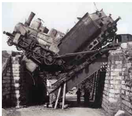
Zničený železniční most nad hlavní silnicí v Mostech ustupující německou armádou - 1945 (foto z knihy Jablunkovské tunely)
