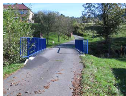
Oprava mostu M9 k čp. 53 a montáž zábradlí
