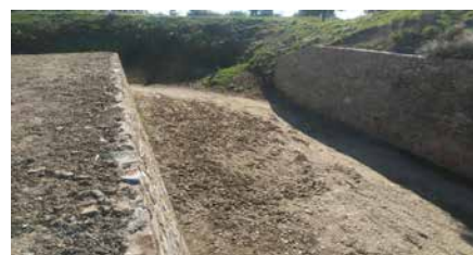
Zpřístupnění stezky v severovýchodní části opevnění
