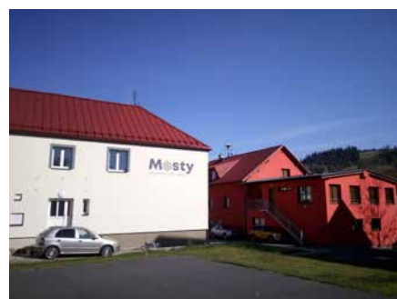
Oprava fasády jižní stěny Sokolovny
