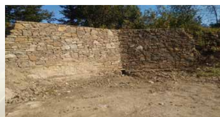
Nově nalezený a opravený propustek v severovýchodní části stezky
