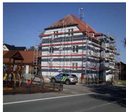
Oprava vnějšku budovy Policie
