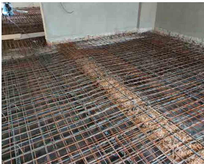
Výztuž nové stropní desky
