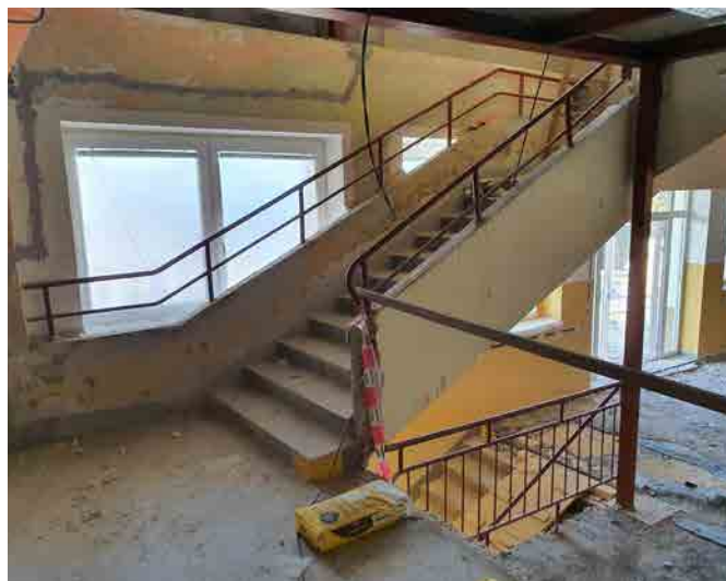
Schodiště do 2. NP během rekonstrukce
