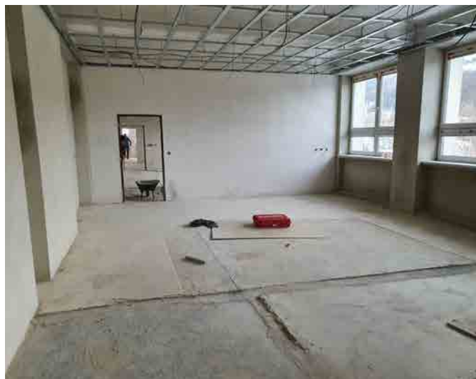
Učebny ve fázi rekonstrukce
