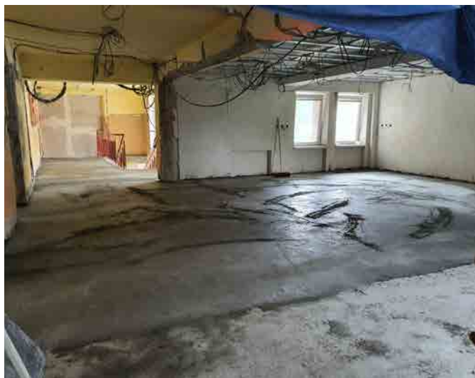
Vybetonovaná nová stropní deska
