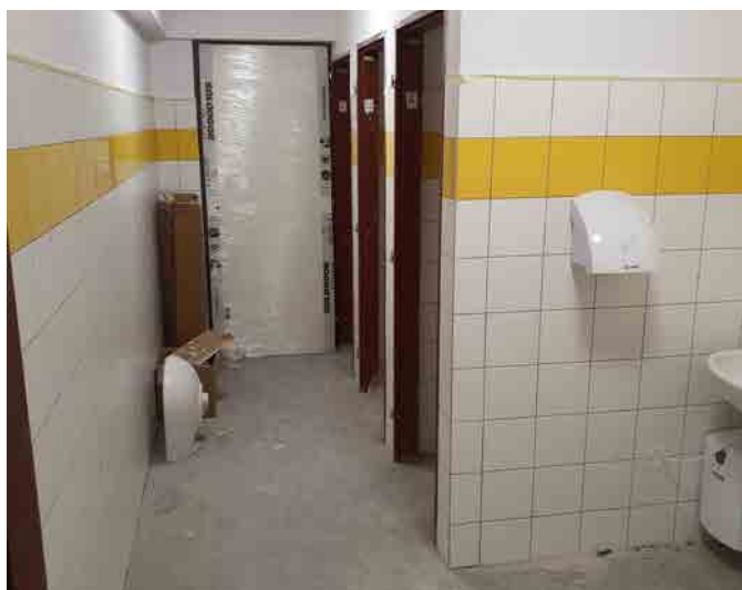
Nové toalety po rekonstrukci
