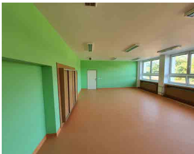
Učebny po rekonstrukci
