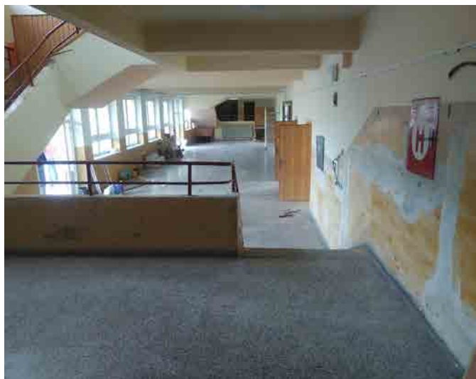
Hlavní chodba před rekonstrukcí
