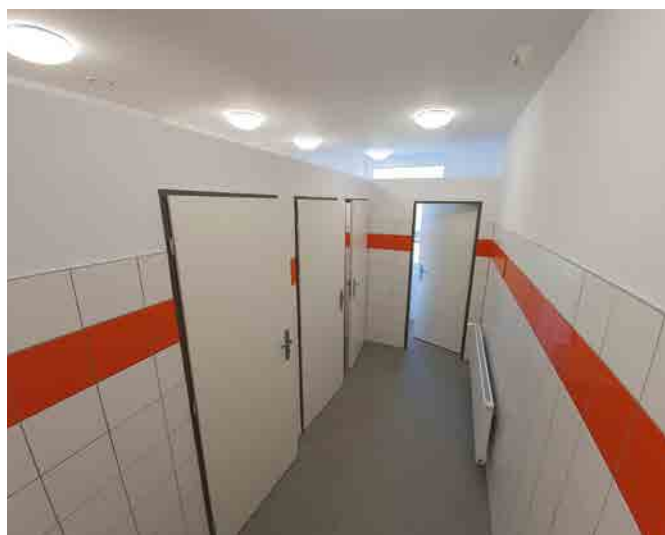
Nové toalety po rekonstrukci
