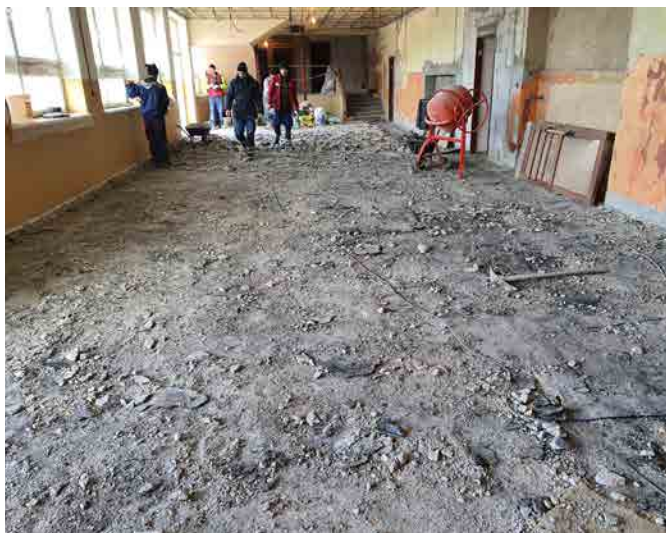
Hlavní chodba během prací
