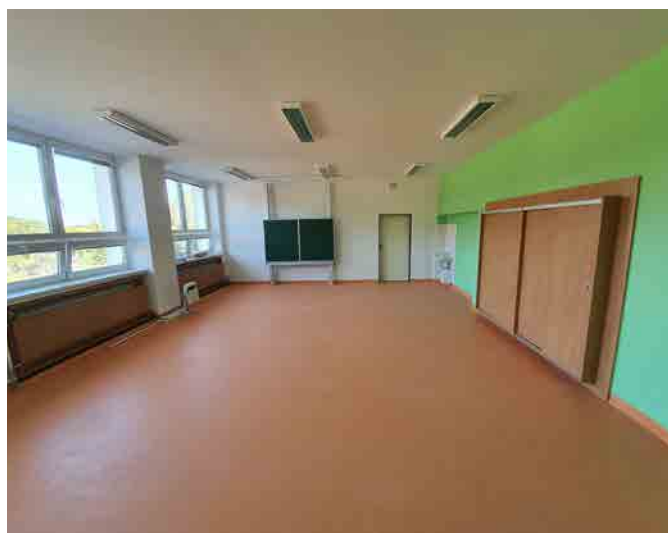
Učebny po rekonstrukci
