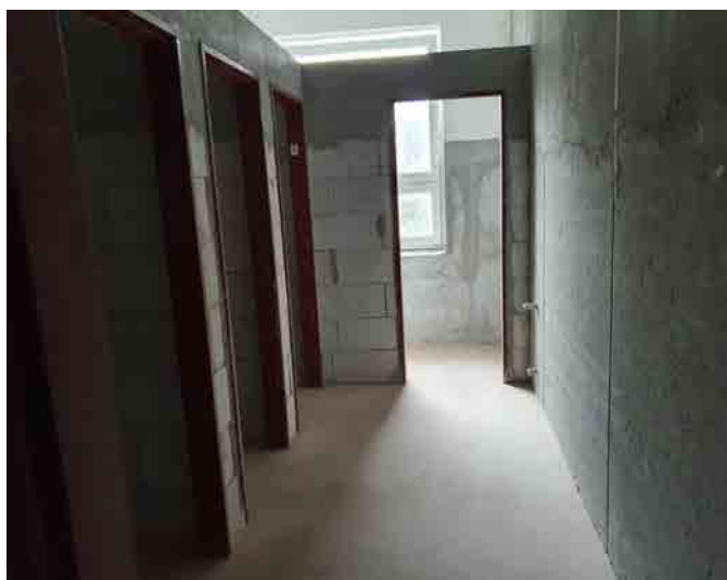
Nová výstavba toalet
