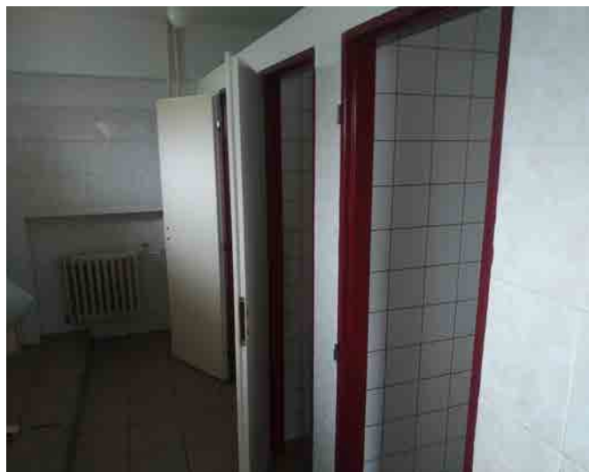
Toalety před rekonstrukcí
