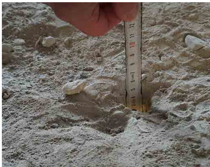
Tloušťka stropní konstrukce v nejtenším místě
