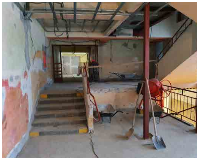
Schodiště do 1. NP během rekonstrukce
