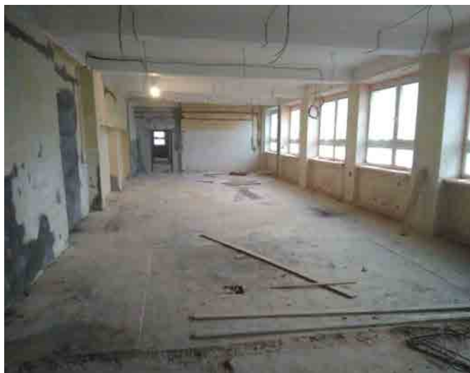
Postup prací na učebnách
