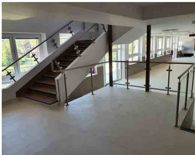
Schodiště do 2. NP po rekonstrukci
