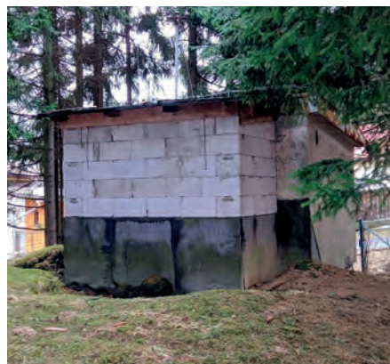
vodojem Bahno před rekonstrukcí
