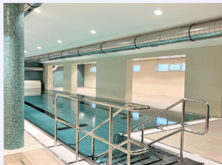
bazén po rekonstrukci
