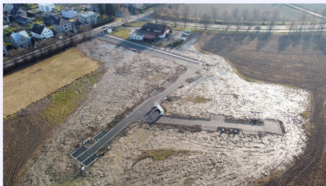
Fotografie po dokončení
