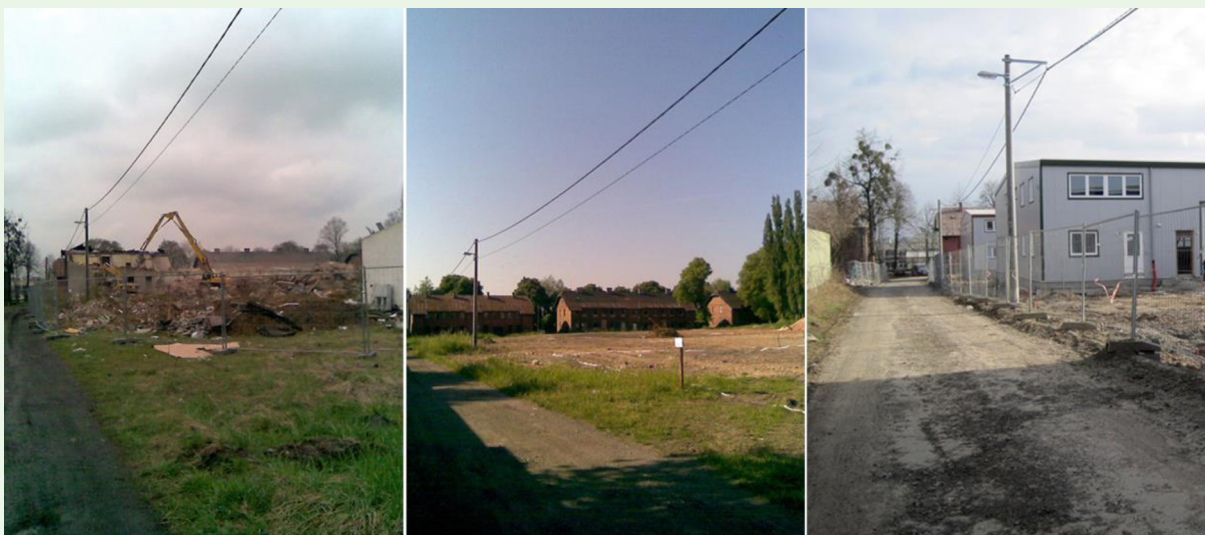
Foto zleva: demolice budovy bývalého odborného učiliště, stav pozemku po demolici, stav současný
