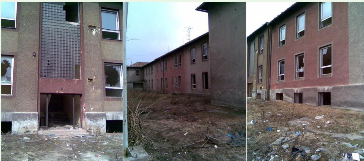
Budova bývalého odborného učiliště - před demolicí
