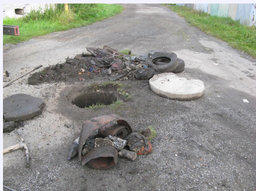
Odpad vytažený z kanalizace
